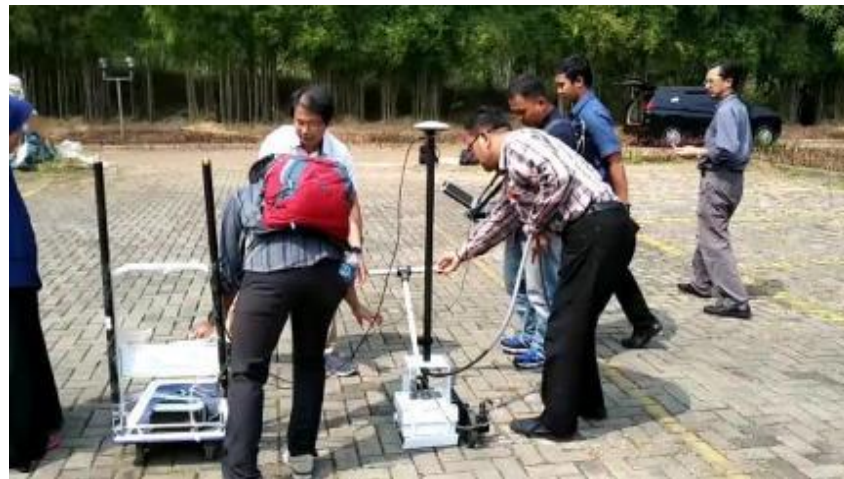
地中埋設物調査 (インドネシア)
