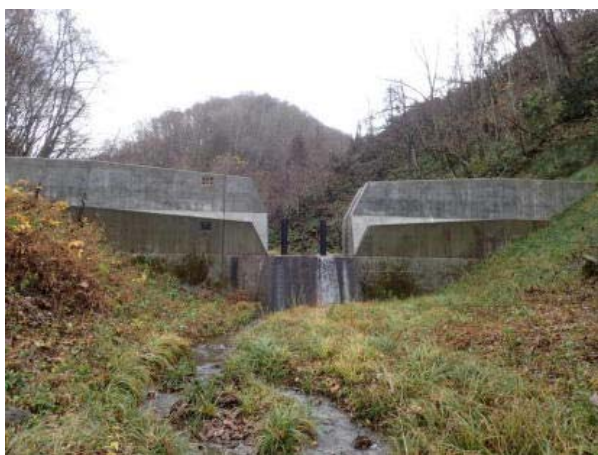
【治山ダム（流木捕捉）（砂川市）】
