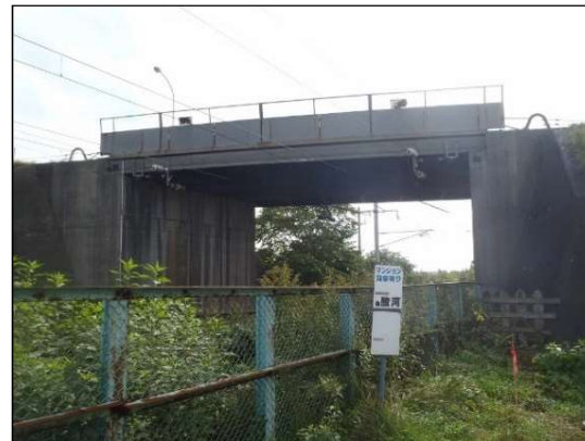
戸磯跨線橋 (現況)
