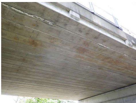
砂川歌志内線 石山跨線橋
