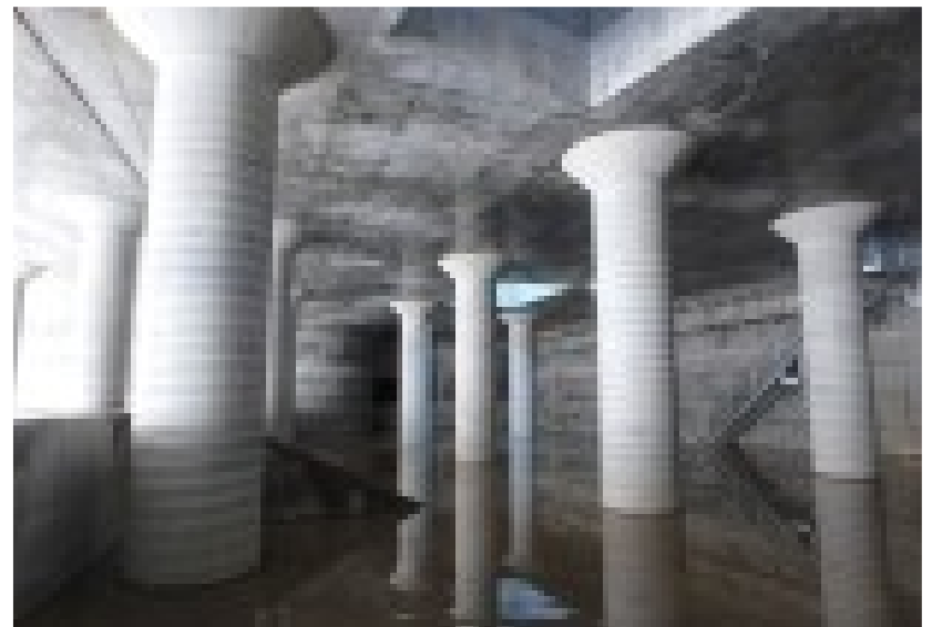
望月寒川放水路トンネル（呑口）
