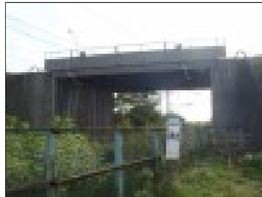
戸磯跨線橋（現況）
