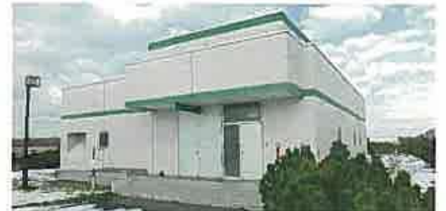
北部ポンプ場
