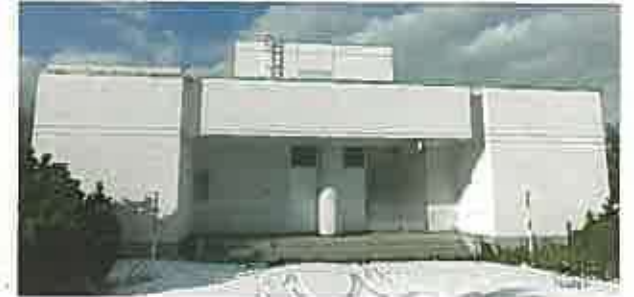
西部ポンプ場
