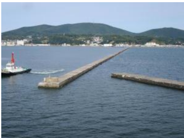
【小樽港北防波堤：小樽市】
