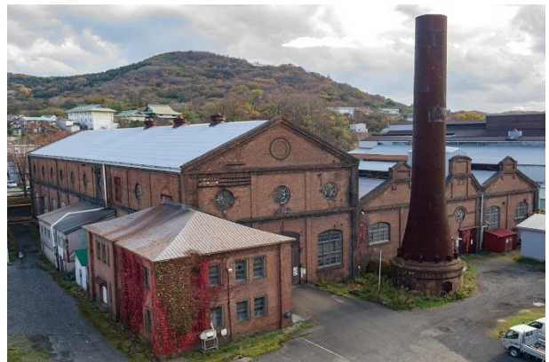
【旧火力発電所（日本製鋼所）：室蘭市】
