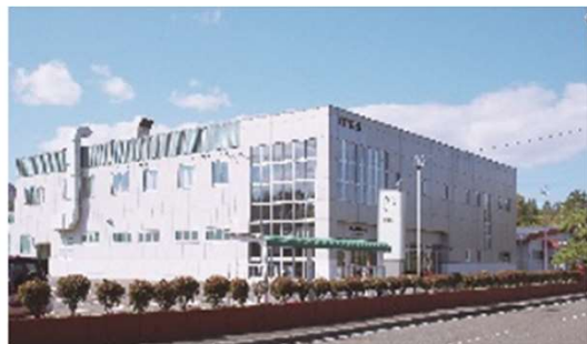
夕張工場 外観
