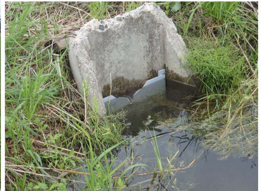
田んぼダム用設備で緩やかに排水
