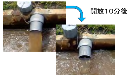
管内に堆積していた土砂が排出されました
