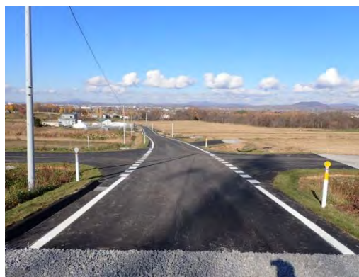
農道完成(音2号線地区:深川市)
