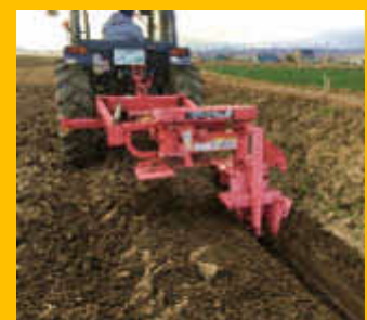
写真1 額縁明きよの施工風景
