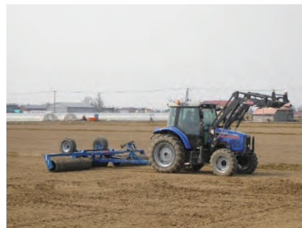
ケンブリッジローラの鎮圧作業
