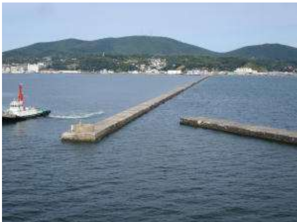
【小樽港北防波堤：小樽市】
