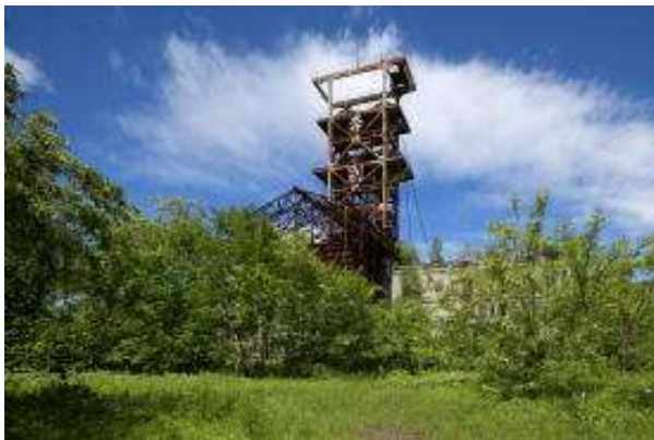
【住友奔別炭鉱立坑櫓・周辺施設：三笠市】
