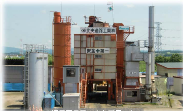
沼田アスファルトプラント
