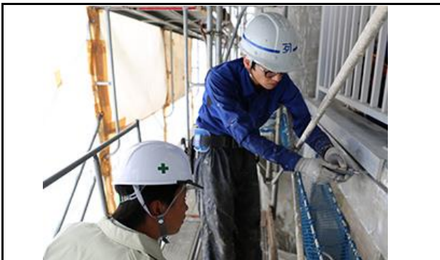
現場において職人さんとの打ち合わせ
