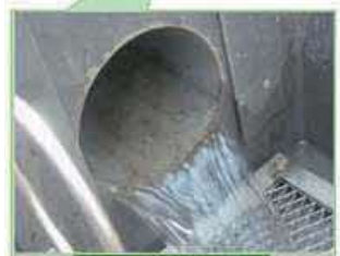
集中管理孔を利用した地下かんがい実施状況
