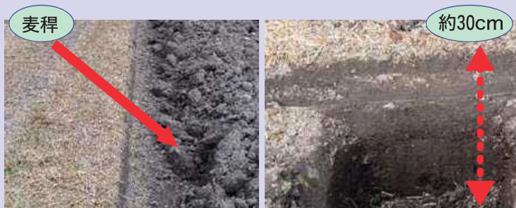
左：施工前 右：施工後
