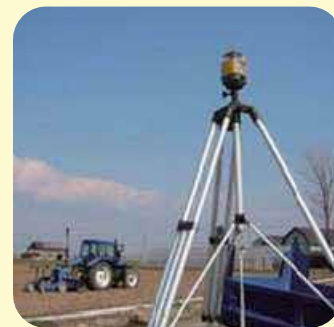
レーザーレベラーによる均平作業
