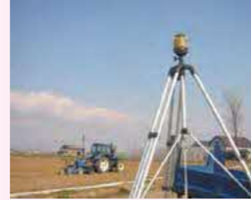
※レーザーレベラーによる均平作業
