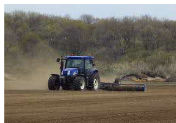
ケンブリッジローラによる鎮圧
