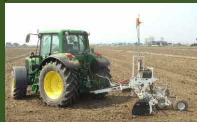
写真28 レーザー均平機施工の様子
