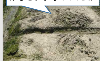
写真40 明渠への水みち (撮影日:H28.7.28)
