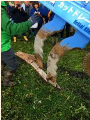
写真35 カットドレーン (施工日:H28.4.9)
