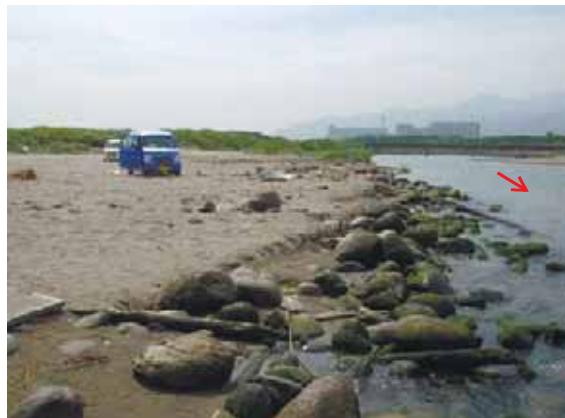
写真-25 長年の流水の作用により破損した既設護岸
