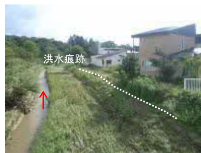
平成 24 年 9 月の豪雨による水位上昇の状況(岩見沢市)
