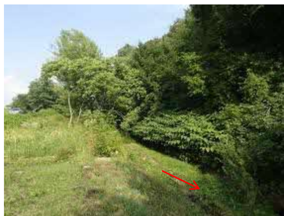
ポントネ川上流端付近の山付き区間
