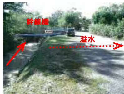
平成 24 年 9 月の豪雨による被災状況(岩見沢市)
