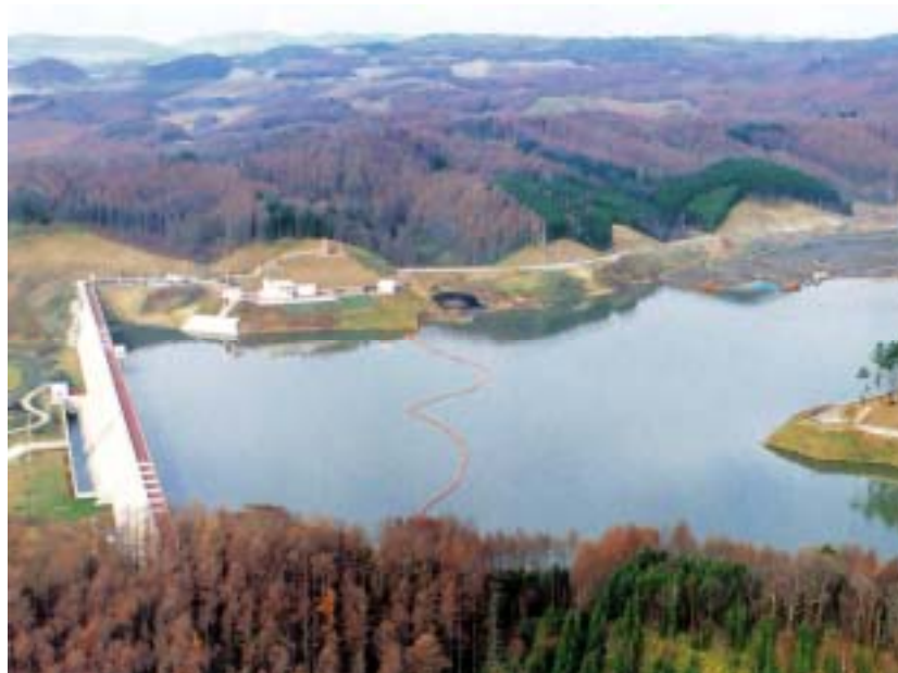
写真 - 15 栗山ダム
