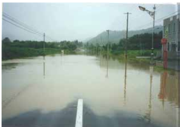
写真－国道 275 号冠水状況 (平成 11 年 7 月洪水、添牛内地区)
