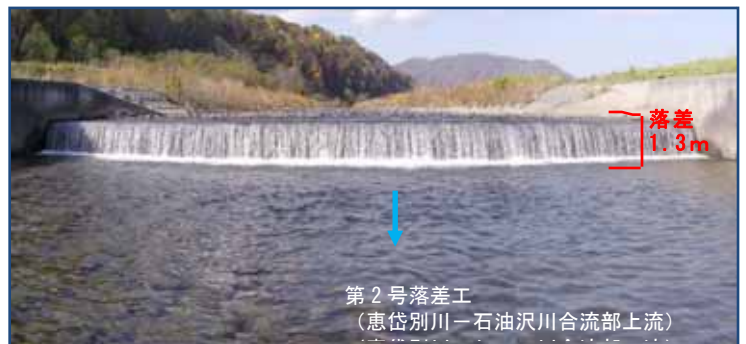
写真－落差工の状況 恵岱別川の状況
