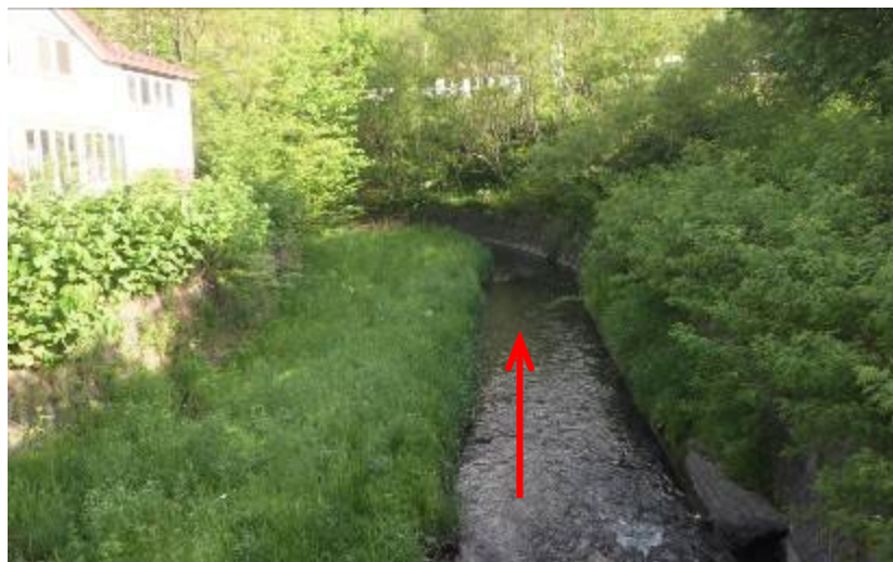
道の駅うたしないチロルの湯付近の河川状況
