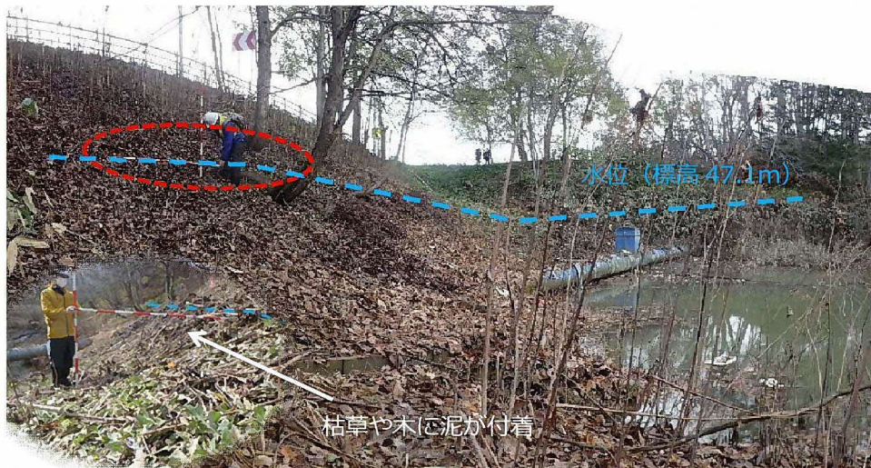
図3-2 R側沢部の滞水状況と上昇した大雨時の水位の痕跡
