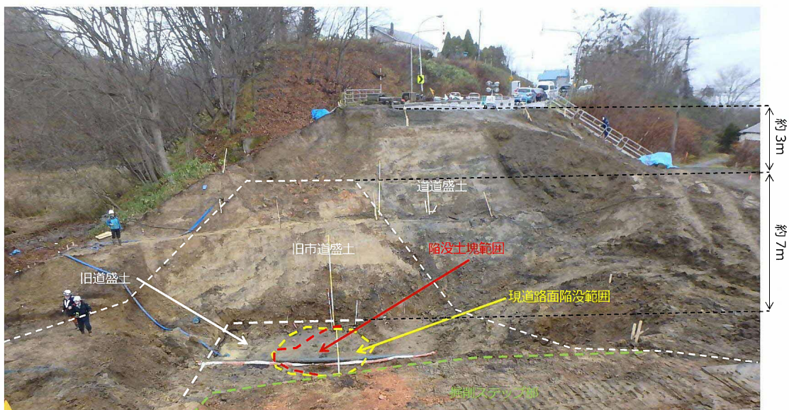
図2-2 調査掘削法面全景
