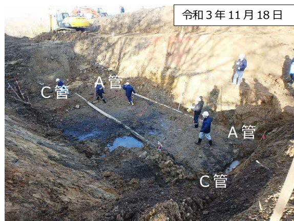
図 2-15 調査掘削で確認した健全な水抜き管 A および C の状況)
