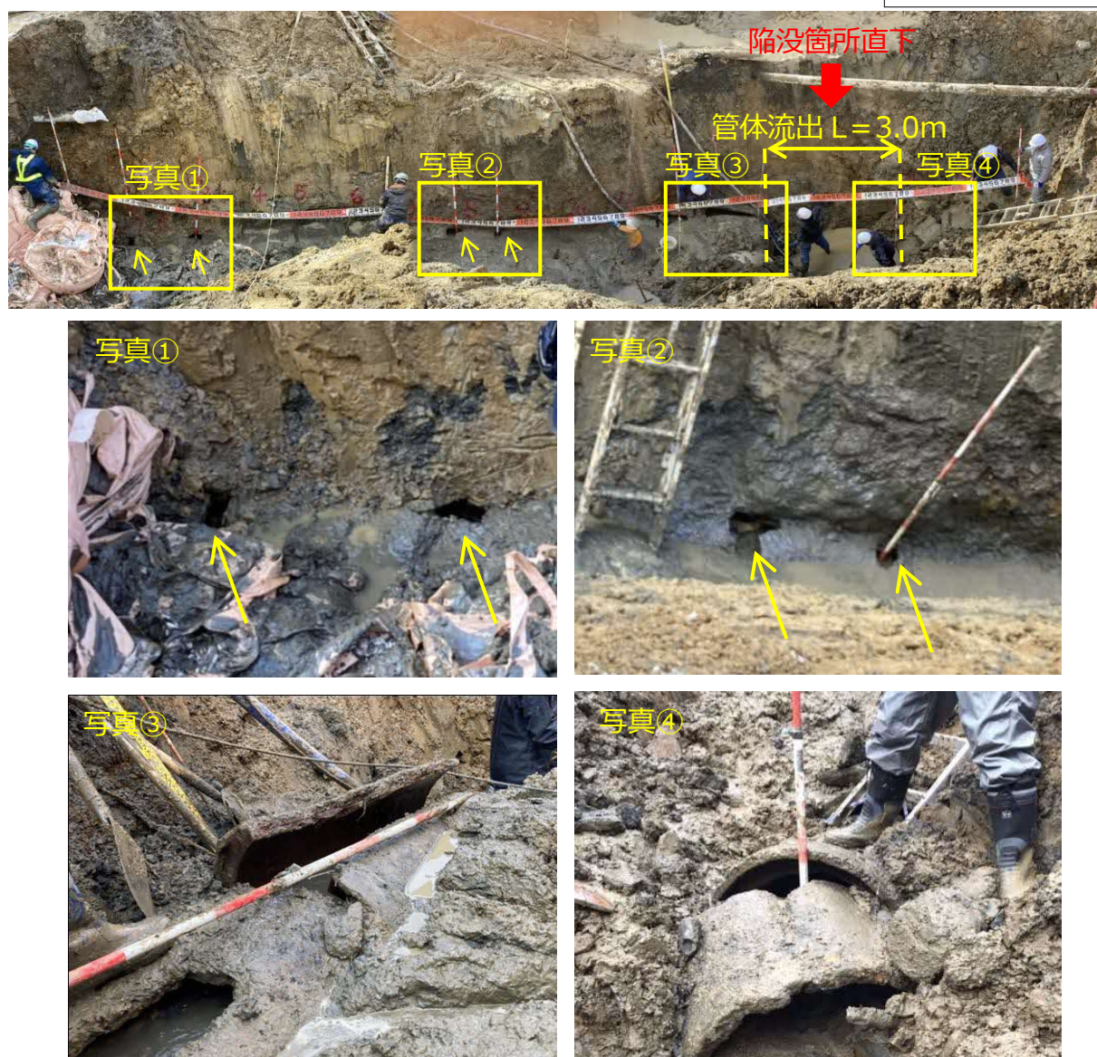
図2-6 横断管の管体流出、頂部・継手等の損傷状況
