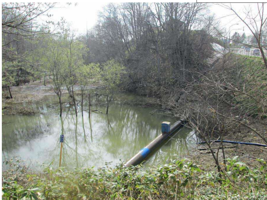
図 1-15 R 側沢部の排水状況
