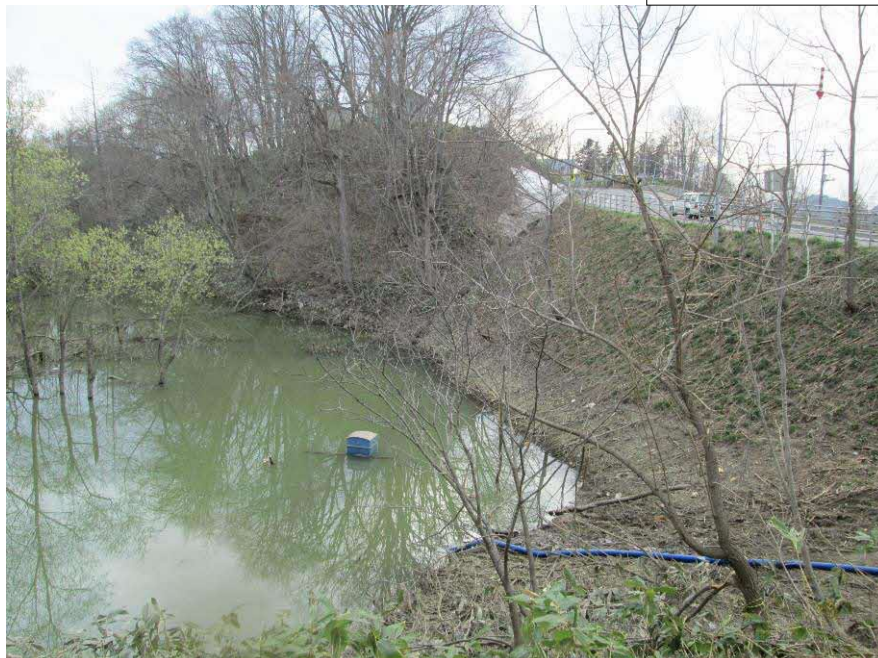
図 1-14 R 側沢部の滞水状況
