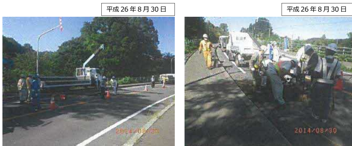
図1-18 路面沈下箇所の最終復旧状況
