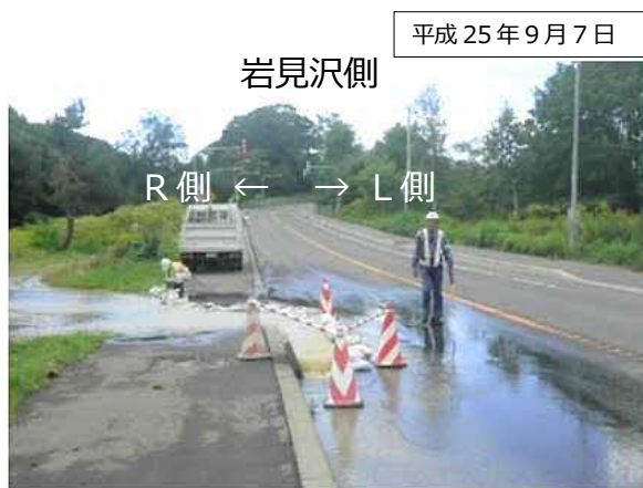
図 1-7 R 側沢部からの沢水の越水状況
