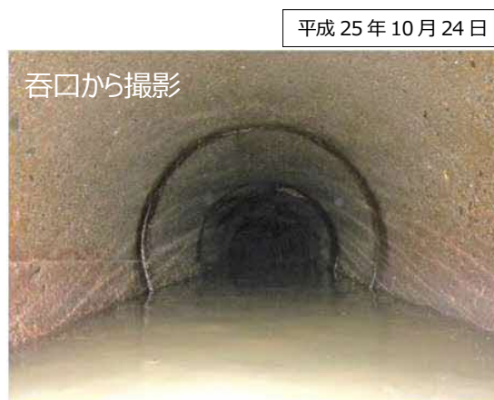
図 1-9 横断管呑口付近の滞水状況
