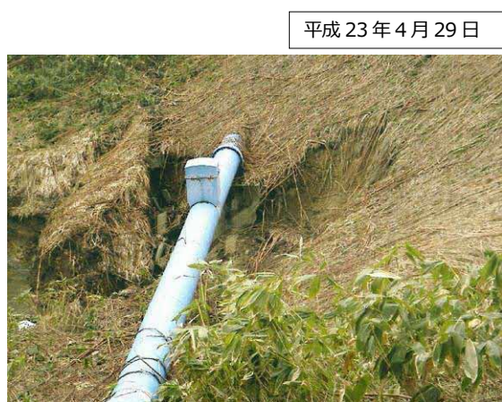
図 1-4 R 側盛土法面崩壊状況
