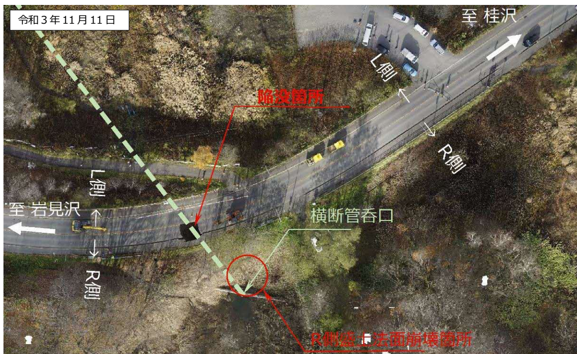
図 1-6 R 側盛土法面の崩壊状況箇所と陥没箇所の位置関係
