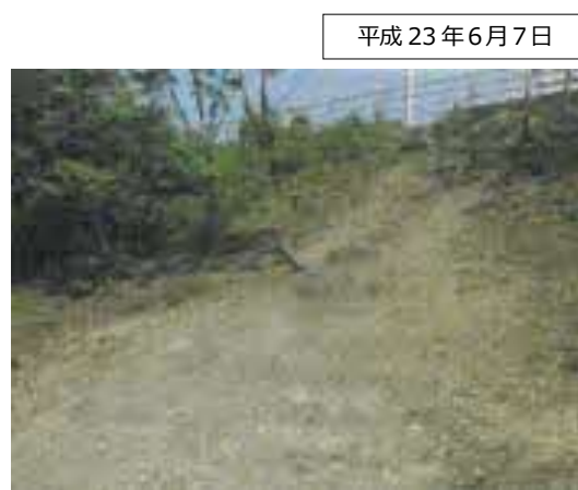
図 1-5 R 側盛土法面補修状況
