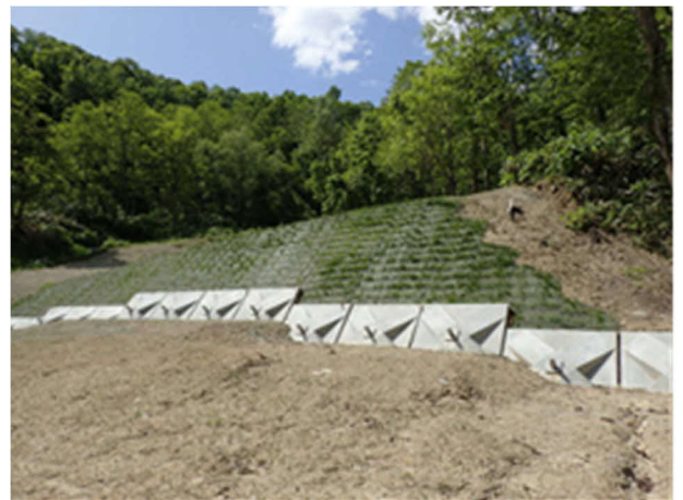
【地すべり防止事業（新十津川町）】
