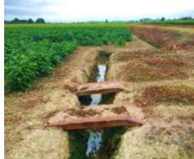
写真12 取り付けに鉄板を敷き、明きよをつなげている
