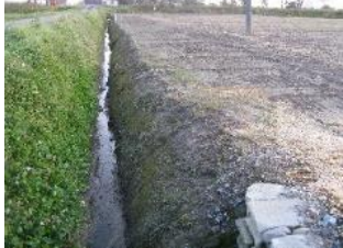
写真11 バックホウで施工した明きよ
