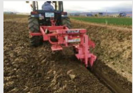
写真4 額縁明きよの施工風景
