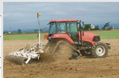
写真5 レーザ-均平機の施工
