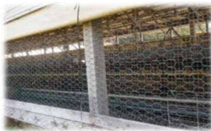
防鳥ネット設置
