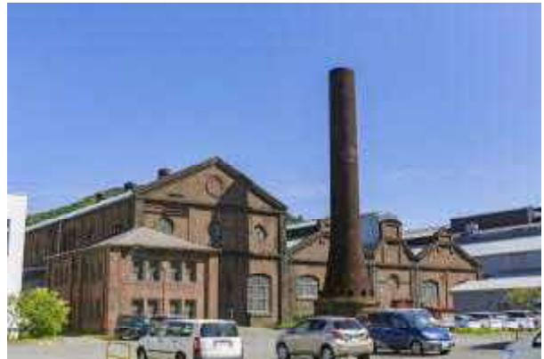
【旧火力発電所（日本製鋼所）：室蘭市】
