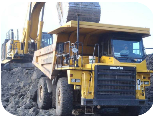
作業風景（ダンプ）
