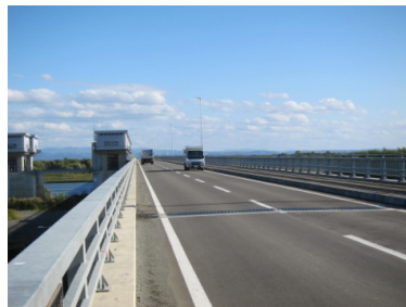
整備された農道橋
