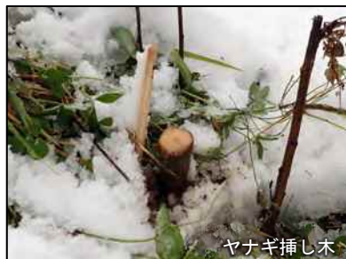
盛土のり面へのヤナギ挿し木実施状況
