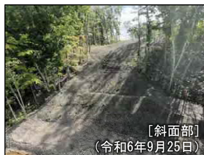
法覆基材工による復元実施状況
