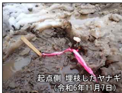
ヤナギ埋枝工+在来種苗導入による復元実施状況
