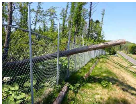
倒木により破損した防鹿柵 (R6.5.14)
