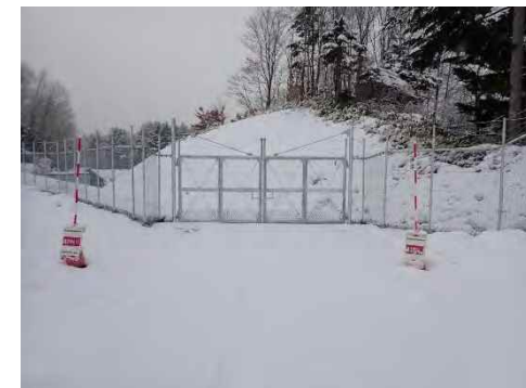
北側取付道路の門扉 (R7.1.24)
