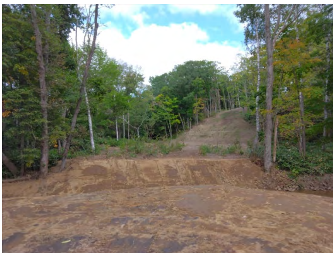
Fビレッジ341橋（旧2号橋）・Fビレッジ73橋（旧3号橋）付近復旧後 横断管撤去・地形復旧・表土ブロック移植工・法覆基材工
