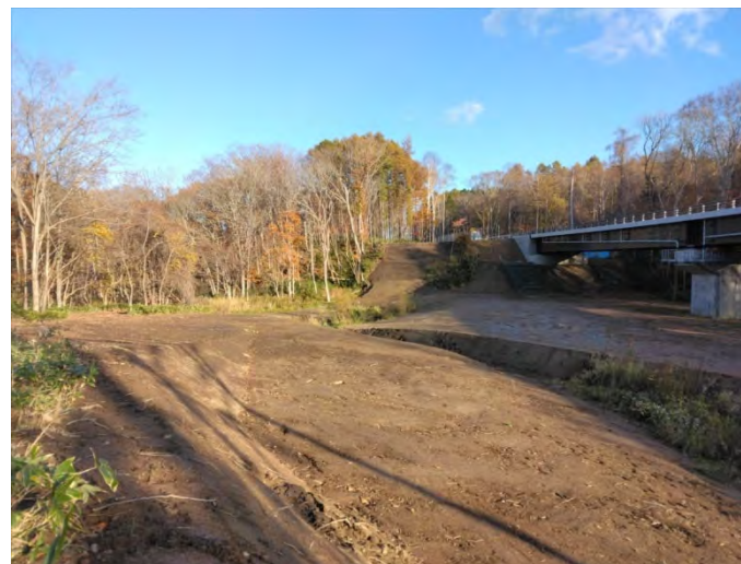
Fビレッジ245橋（旧1号橋）付近 復旧後 横断管撤去・地形復旧・法覆基材工・表土ブロック移植工
