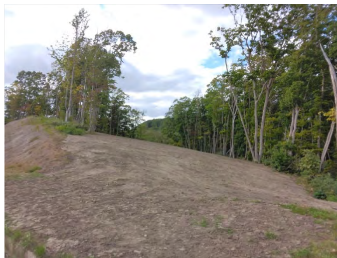
Fビレッジ341橋（旧2号橋）・Fビレッジ73橋（旧3号橋）付近復旧後 横断管撤去・地形復旧・表土ブロック移植工・法覆基材工
