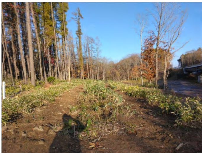
Fビレッジ245橋（旧1号橋）付近 復旧後 横断管撤去・地形復旧・法覆基材工・表土ブロック移植工
