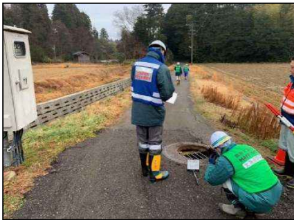
【農業集落排水施設の調査】
