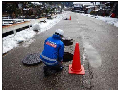
【被災施設の調査】
