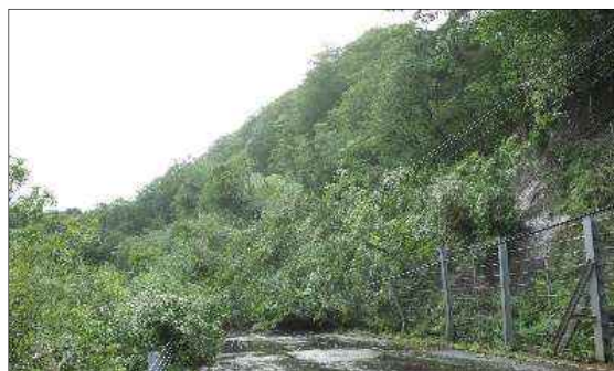
【表層崩壊箇所の現地状況】
