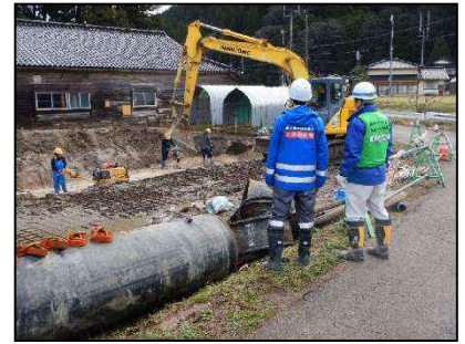
【復旧工事の状況】
