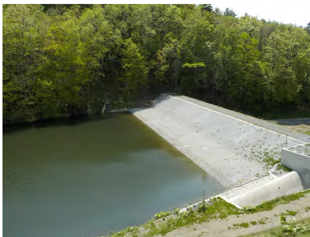
ため池(継立ため池1地区:栗山町)
