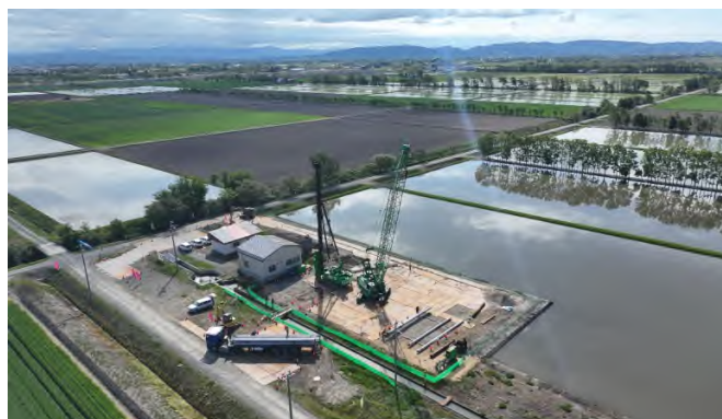
泥炭地域での基礎杭工(暁第1地区:南幌町)
