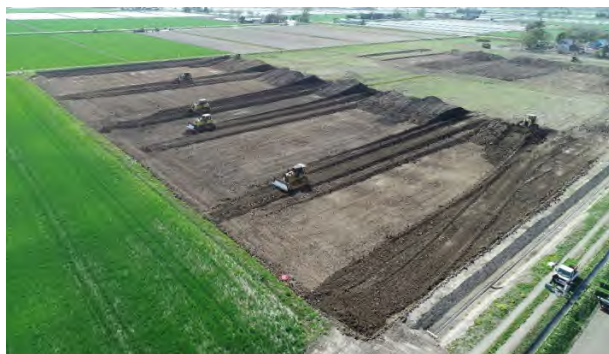
区画整理工事中(三重地区:南幌町)
