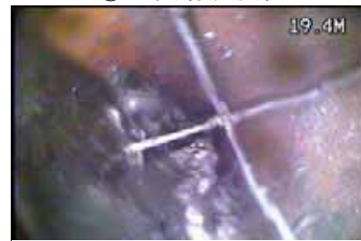
写真-2 堆泥状況 （③AS 圃場吸水渠）
