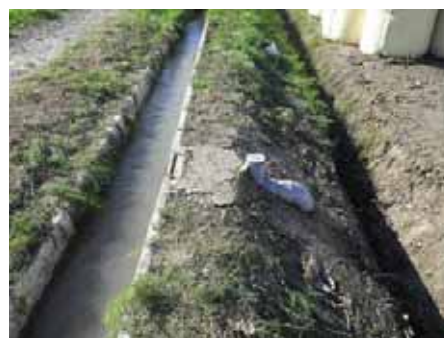
写真-4 集水渠と用水路の接続
