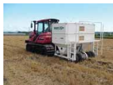
写真-8 補助暗渠施工状況
