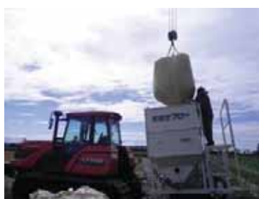
写真-7 施工機械へのモミガラ積込
