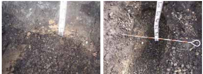
写真-1 既設暗渠の状況
