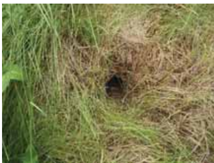
写真.暗きょ落口の埋没
