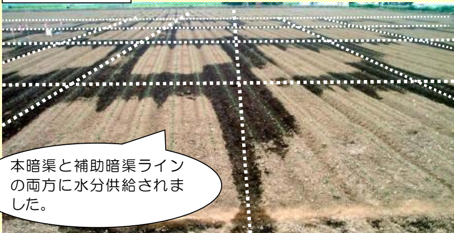
補助暗渠・施工後
