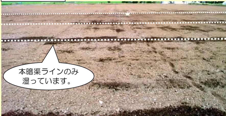
補助暗渠・施工前
