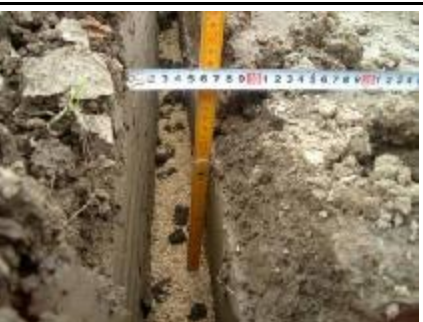
補助暗渠の施工断面図
