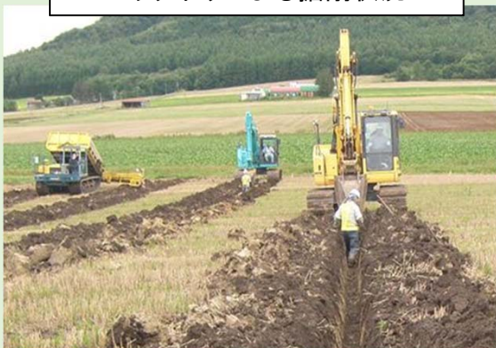
バックホウによる掘削状況
