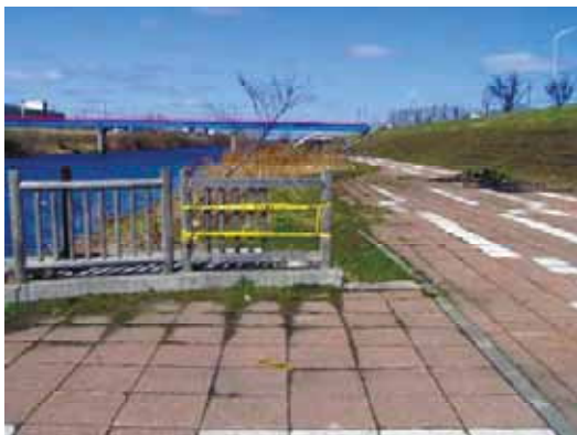
写真－30 転落防止柵の補修
