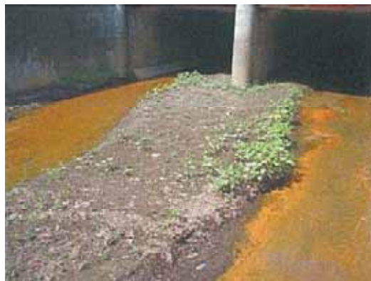
写真－31 樋門土砂の除去
