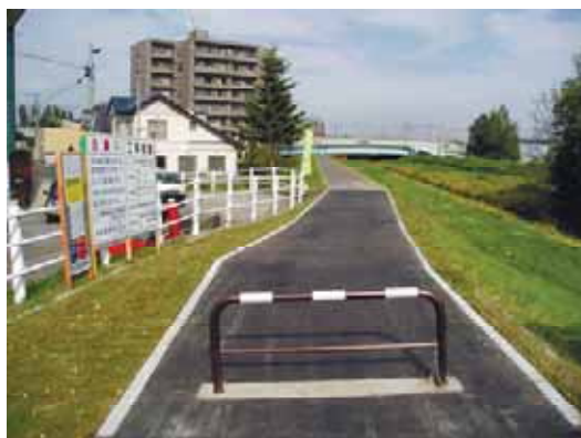
写真-26 堤防天端の維持管理
