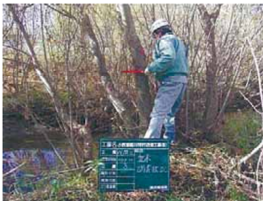
写真－28 河道内樹木の管理
