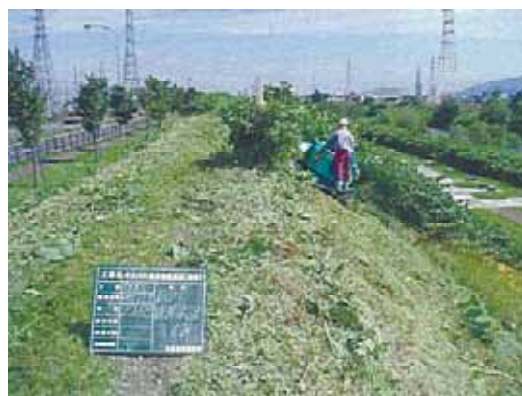
写真-27 堤防の除草
